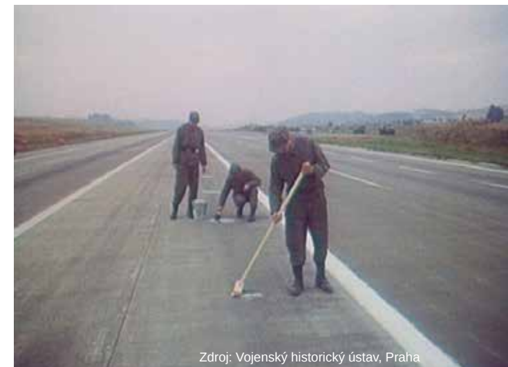
Zaplňování nerovností po pokleslých patních deskách demontovatelných svodidel ve středním pásu
