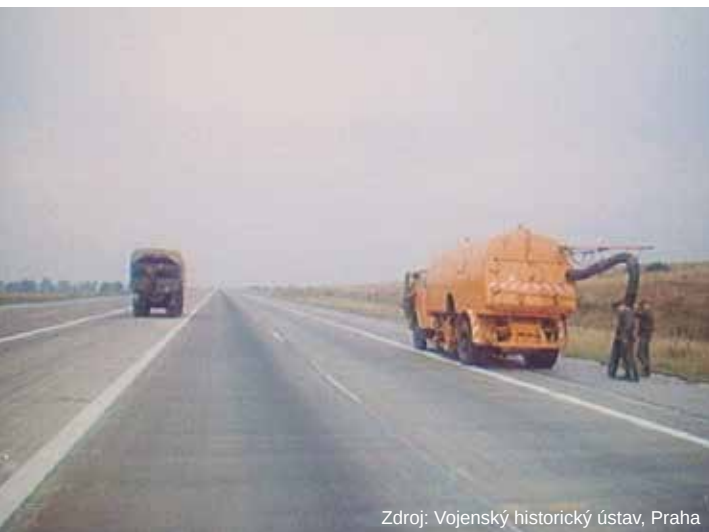
Vojáci za pomoci zametače SSÚD 3 čistí poklopy kanalizačních šachet na krajnici
