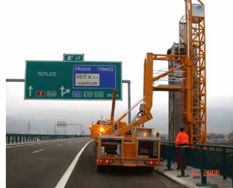
Mostní prohlížečka na mostě přes tratě ČD v Trmicích na stavbě 0807/1 B dálnice D 8 dne 1. prosince 2006
