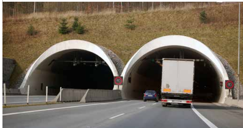
Pražské portály tunelu Valík na stavbě 0510/I-B dálnice D 5 dne 25. března 2014
