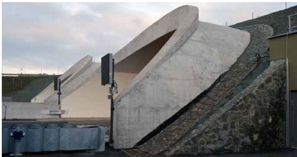
Ústecké portály tunelu Radejčín na stavbě 0805 F dálnice D 8 dne 16. prosince 2016
