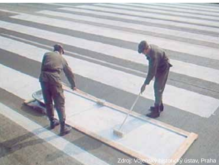
Označení prahu vzletové a přistávací dráhy na konci S-úseku kaseinovými barvami
