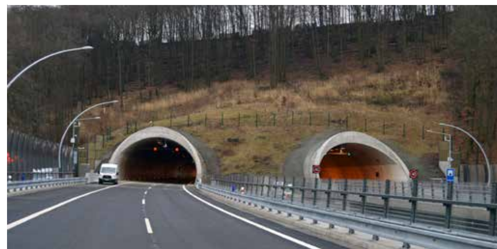
Ústecké portály tunelu Prackovice na stavbě 0805 E dálnice D 8 dne 16. prosince 2016
