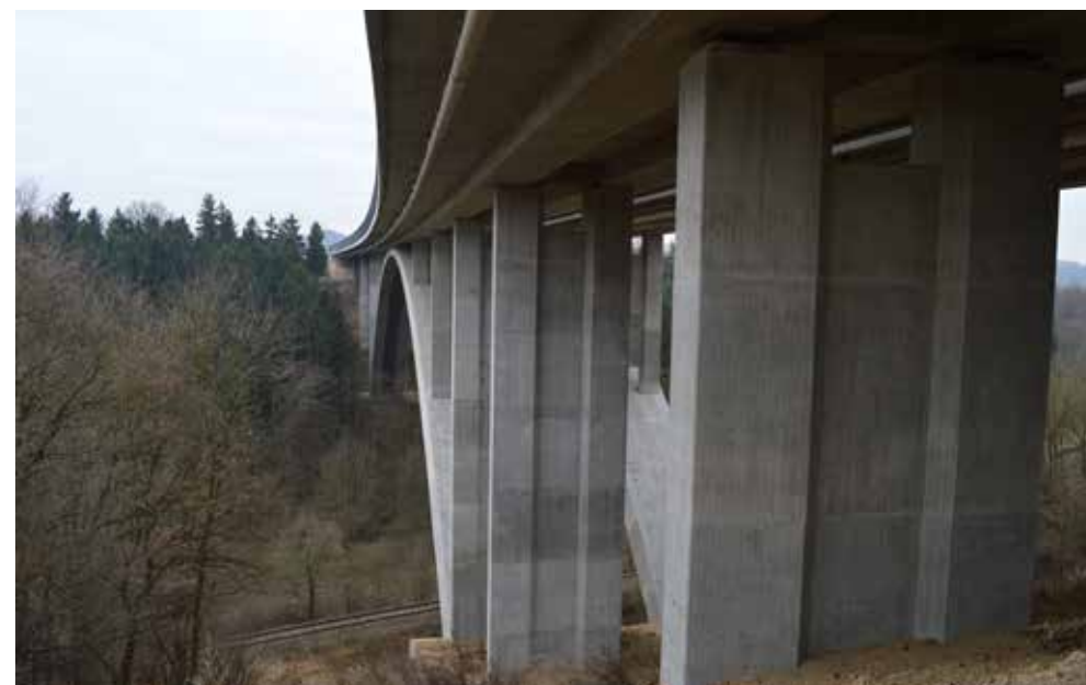
Most přes údolí u Opárna na stavbě 0805 C dálnice D 8 dne 13. prosince 2016
