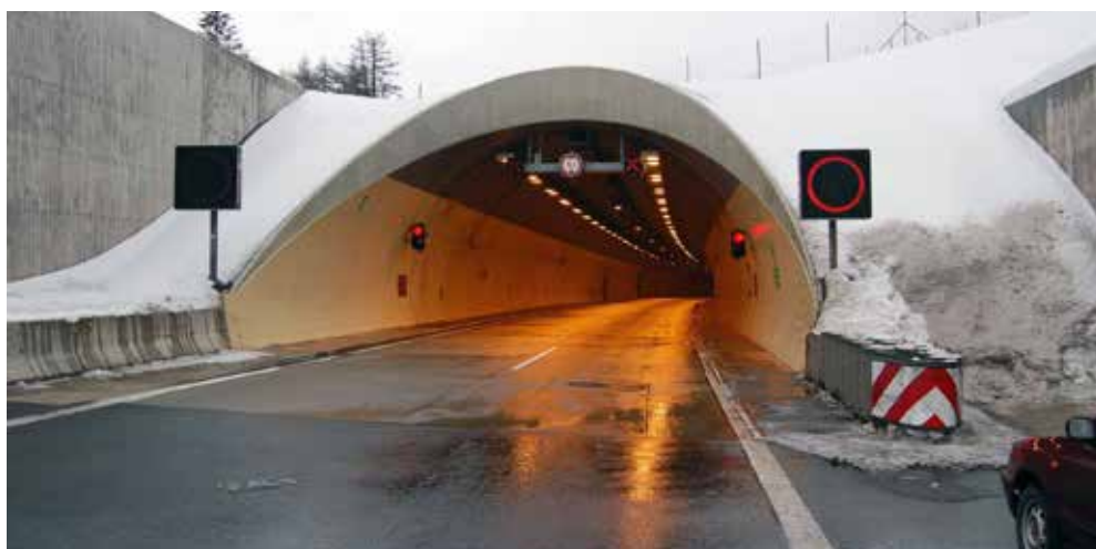
Severní portál levé trouby tunelu Panenská na stavbě 0807/II-G dálnice D 8 dne 10. března 2009
