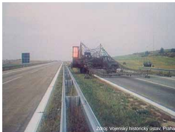
Světelný maják instalovaný před začátkem dráhy v km 140,0 vlevo
