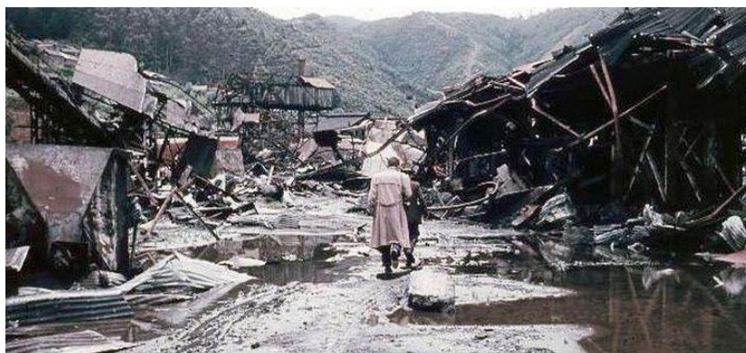
Následky po nejintenzivnějším zemětřesení na světě – Chile v roce 1960, magnitudo 9,5
